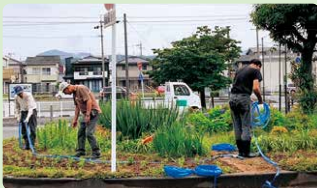
スプリンクラーの設置
